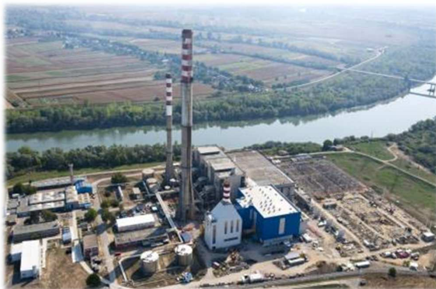
Stanje na gradilištu u 2013.
