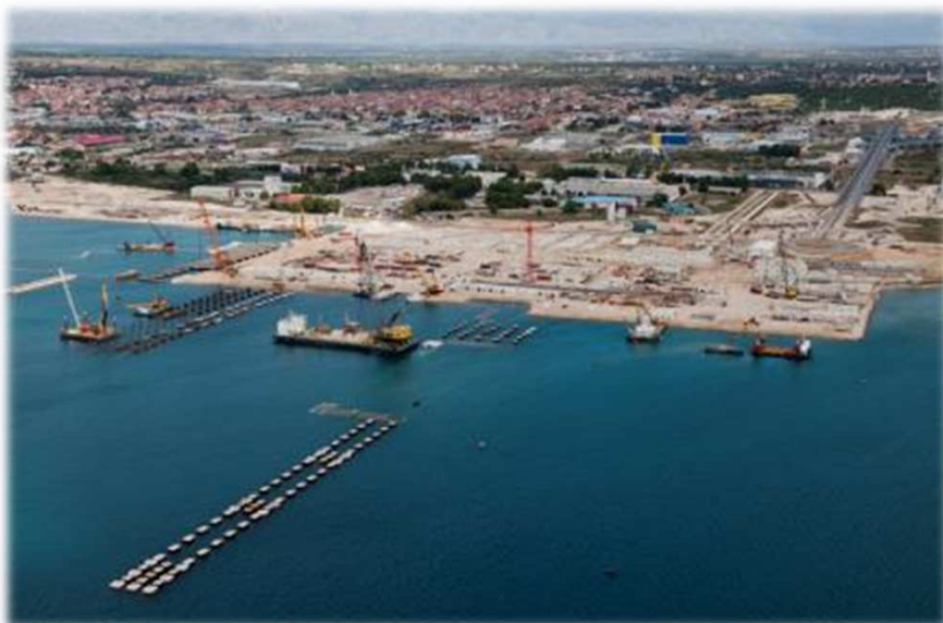
Stanje na gradilištu u 2012.
