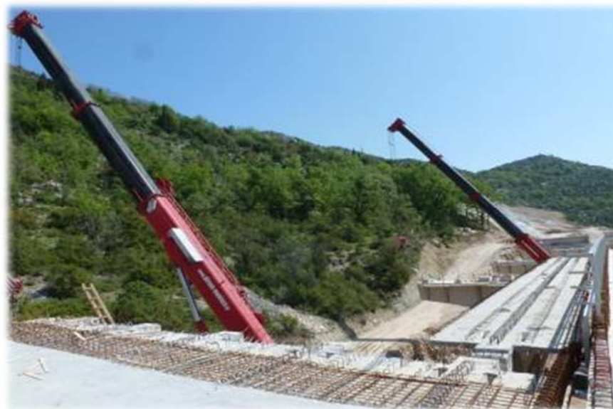
Stanje na gradilištu u 2013.
