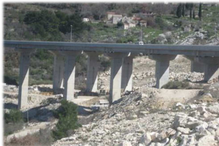
Stanje na gradilištu u 2013.
