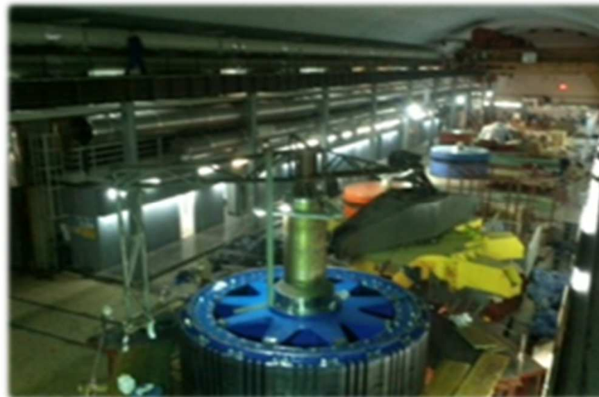
Stanje na gradilištu u 2013.
