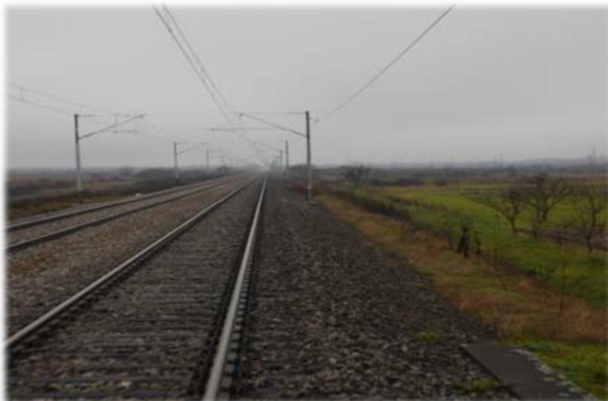
Stanje na gradilištu u 2012.
