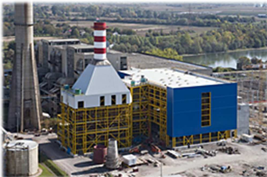
Stanje na gradilištu u 2012.
