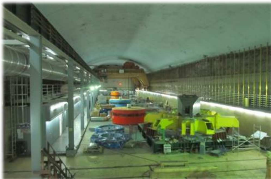
Stanje na gradilištu u 2012.
