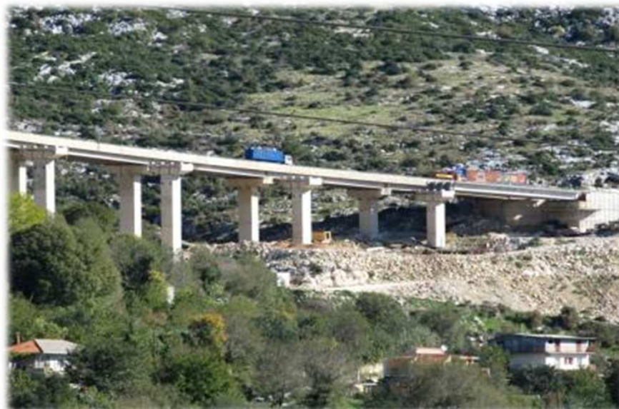
Stanje na gradilištu u 2012.
