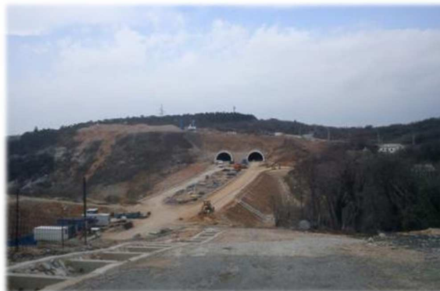
Stanje na gradilištu u 2013.
