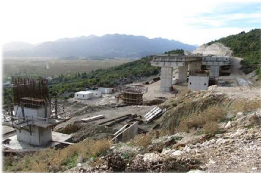
Stanje na gradilištu u 2012.
