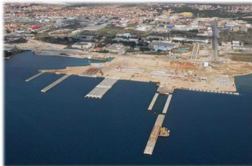
Stanje na gradilištu u 2013.
