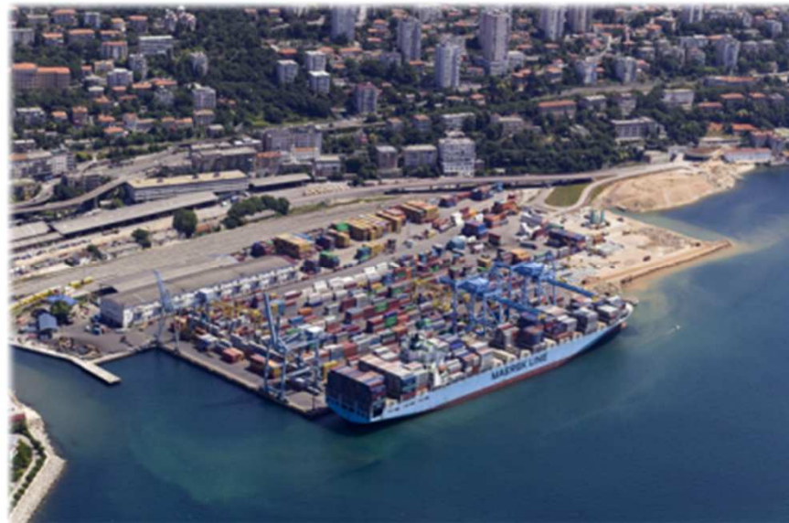
Stanje na gradilištu u 2013.
