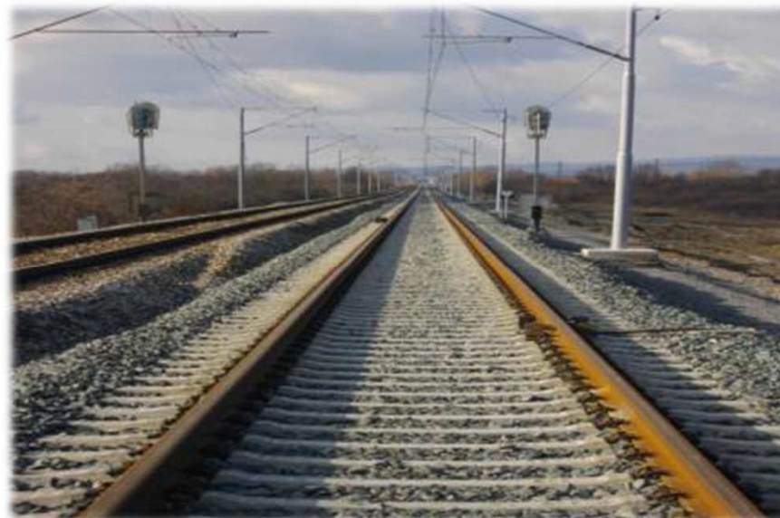
Stanje na gradilištu u 2013.
