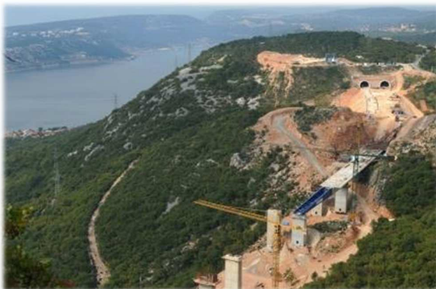
Stanje na gradilištu u 2012.
