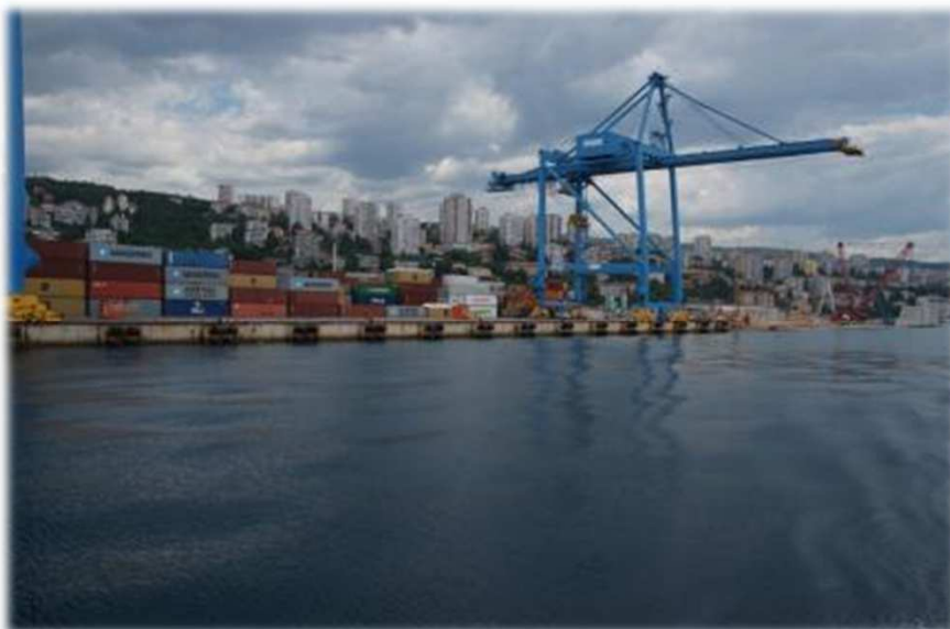
Stanje na gradilištu u 2012.
